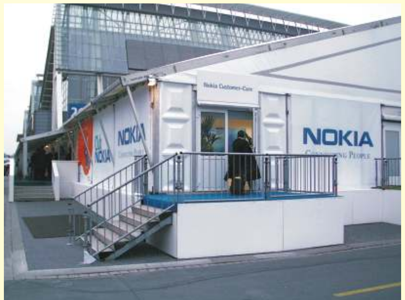
32 m freitragend, 1,20 m Unterbau
